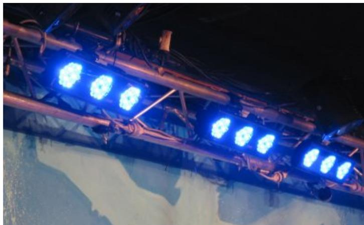
*4 Moduled 318 (marque Ayrton) : Pour les contre-jour, 4 Moduled 318 (marque Ayrton), ces éclairages utilisent des lampes à LED d'une puissance de 1 watts en RGB soit 16 millions de couleurs. La Moduled se compose de trois*
